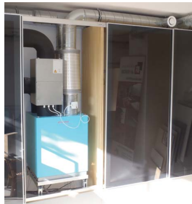
Obr. 12 Větrací jednotku lze umístit pod strop v komunikačním prostoru, do koupelny nebo třeba i do skříňe vstupní haly. Rozvody jsou pak řešeny pod stropem v podhledu nebo i příznané v interiéru. (Zdroj TAUSCH)
