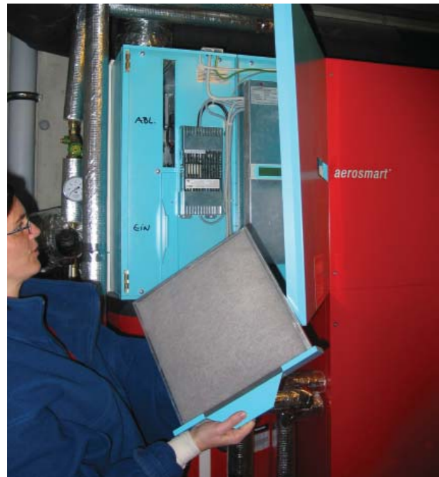
Pravidelná výměna filtrů 2 až 4 krát ročně má zásadní vliv na udržení nízké prašnosti v rozvodech i samotném rekuperačním výměníku.
