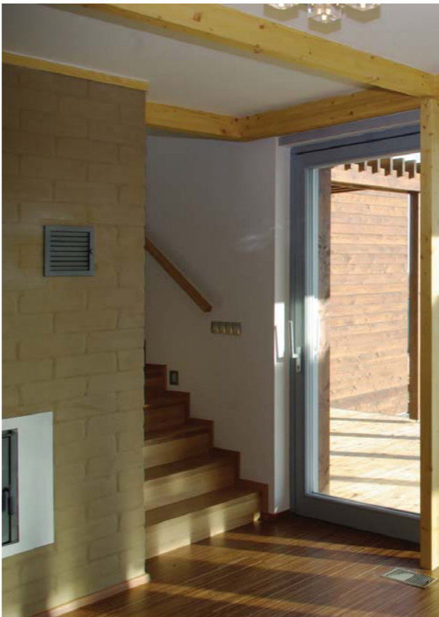
Obr. 4 Vnitřní vlhkost regulují i hydroakumulační plochy např. ve formě přízdvek z nepálených cihel. Díky vysokému obsahu jílu a jeho sorpční schopnosti jsou schopny přijímat značné množství vlhkosti v době její produkce a zpětně ji se zpožděním uvolňovat. Dochází tím přirozeně k regulaci vlhkosti v interiéru. (Foto Slavona)
