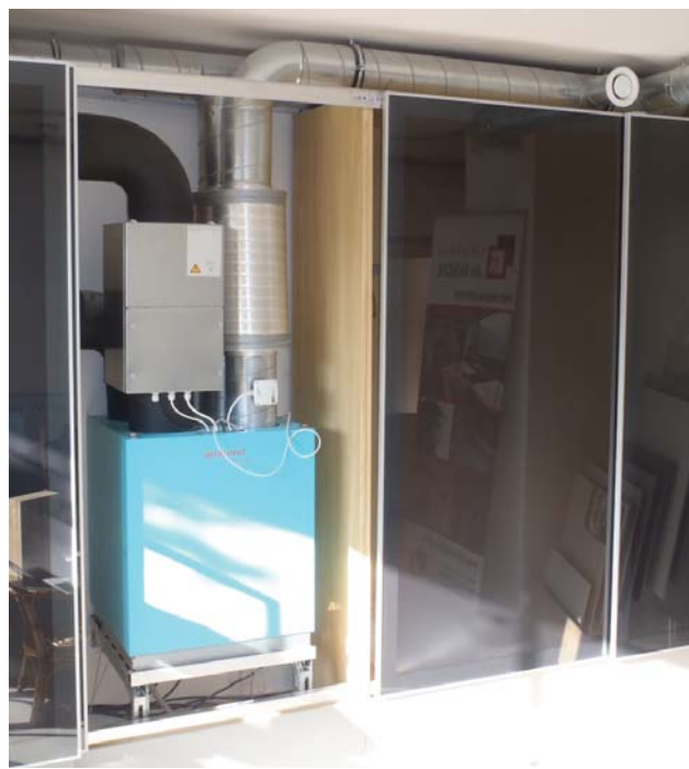
Obr. 9 Umístění jednotky přímo v interiéru do skříně. Je vidět pěkné řešení s tlumiči hluku za jednotkou a protimrazovou ochranou rekuperačního výměníku. (Zdroj TAUSCH)
