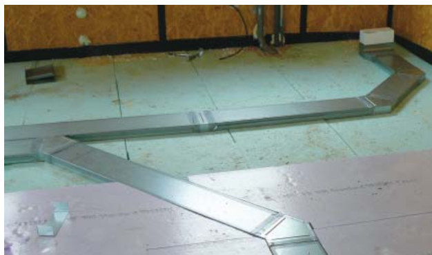
Obr. 12 Rozvody v podlaze a pod stropem. Výhodou rozvodů pod stropem je jejich kratší délka a jednodušší koordinace profesí během stavby.
