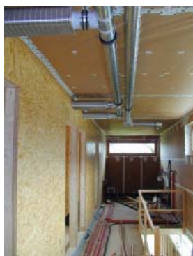
Obr. 12 Rozvody v podlaze a pod stropem. Výhodou rozvodů pod stropem je jejich kratší délka a jednodušší koordinace profesí během stavby.
