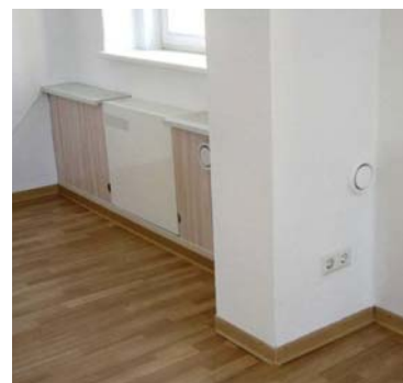
Obr. 10 Pokud situace neumožňuje centrální odvětrání bytu nebo prostoru, lze potřebnou výměnu vzduchu zabezpečit i malými nástěnnými jednotkami. Řešení může být výhodné u malých prostor nebo rekonstruovaných objektů. Vzhledem ke kompaktním rozměrům se však jednotky často potýkají se sníženou účinností a vyšším hlukem.
