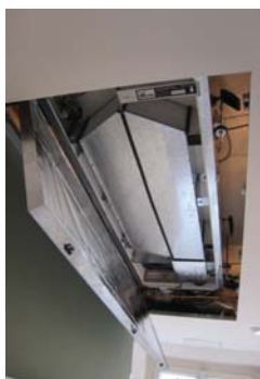
Obr. 8 Umístění jednotky je možné pod stropem v komunikačním prostoru (vlevo), v technické místnosti nebo i přímo v interiéru do skříně v podhledu (vpravo). Důležité je nezapomenout na revizní otvor pro výměnu filtrů a kontrolu jednotky. Je vidět pěkné řešení s tlumiči hluku za jednotkou a protimrazovou ochranou (zdroj Paul Rekuperace)
