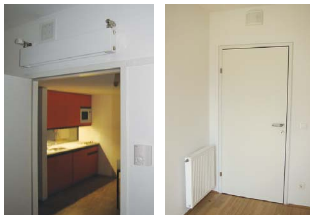
Obr. 15 Kombinace větrání a otopného zdroje v místě výústky poskytuje dobrou regulovatelnost a nízké vstupní náklady (vlevo). Jednoduchým a levným řešením může být například radiátor za dveřmi. Vnitřní dispozice pak zůstává volná.
