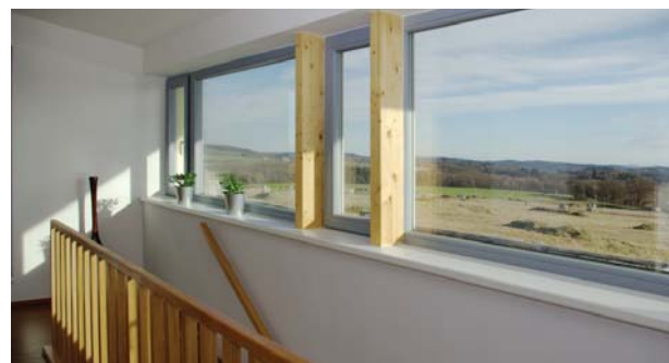
Obr. 10 Revoluci v zasklení může způsobit systém multifólií, který dosahuje izolačních vlastností stěn, a přitom má vysokou propustnost sluneční energie. (Zdroj Superwindows)
