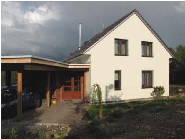
Obr. 2 Podmínkou pasivního domu nemusí být nutně velké prosklené plochy. Na první pohled jej vůbec nemusíte rozeznat od běžné výstavby. (Foto Aleš Brotánek)
